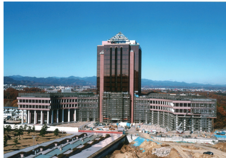
片柳研究所棟の建築中の様子
