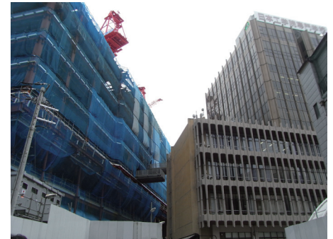
蒲田キャンパス再開発の様子 左：建築中の新3号館 右：解体前の旧3号館
